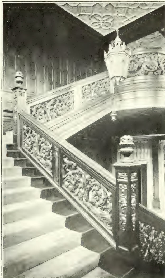
CHATEAU DE ROSLYN — Le grand escalier, remarquable par les superbes sculptures de ses rampes.
